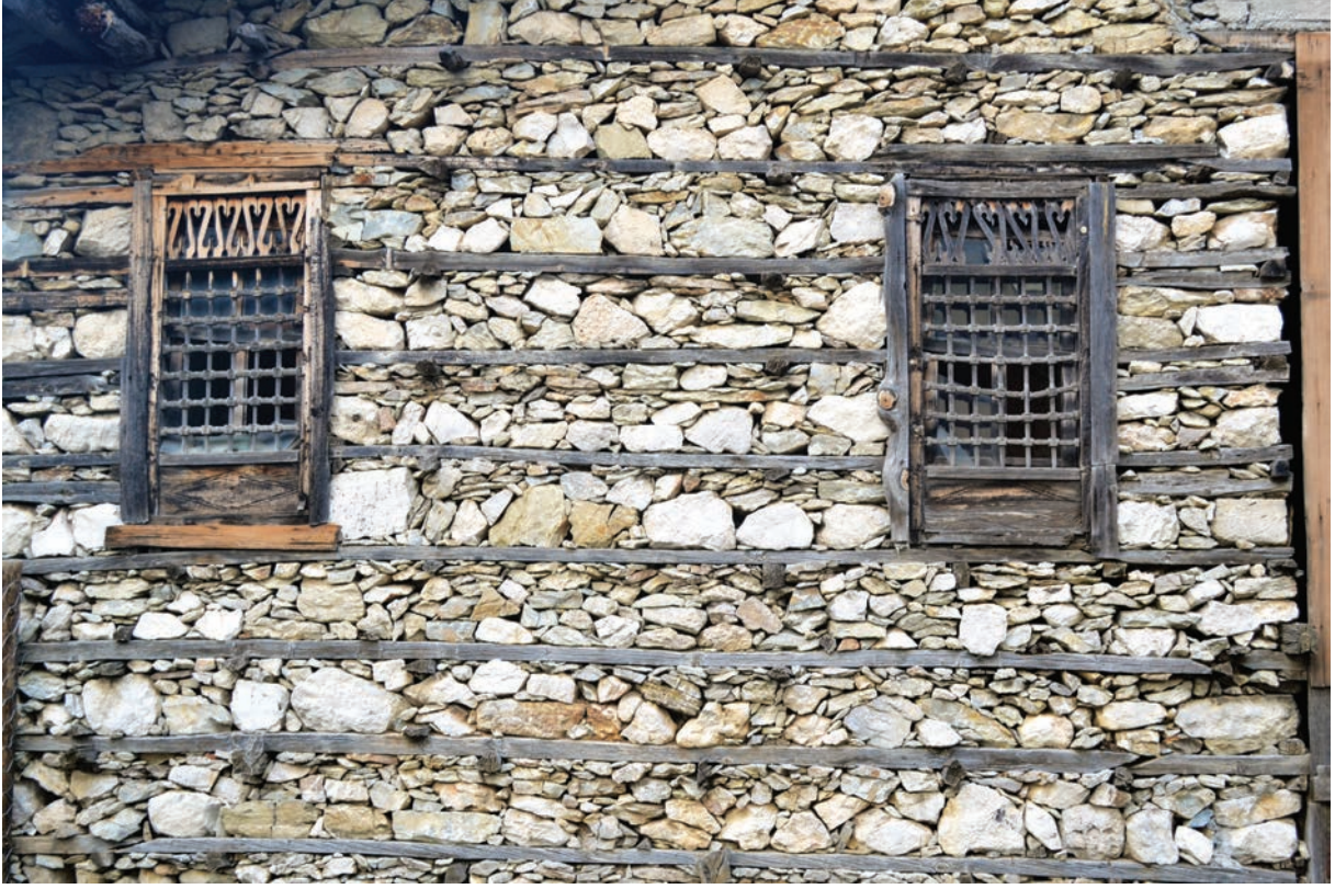
Şekil 2. Yöreye özgü duvar tekniği.
