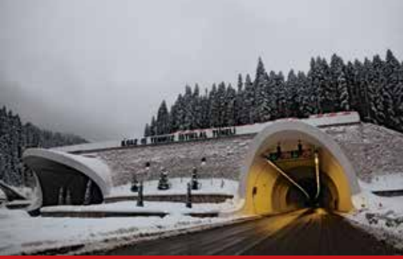
Ilgaz 15 Temmuz İstiklal Tüneli
