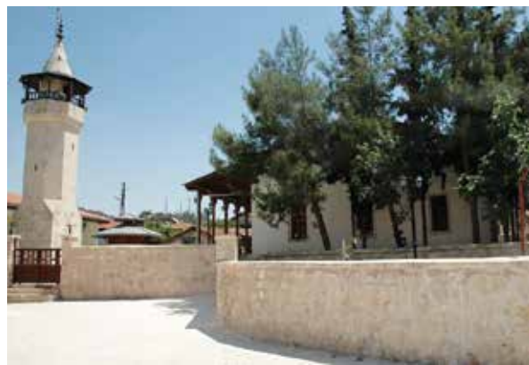
Kasım Bey Camii ve Minaresi
