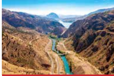
Suşehri Kılıçkaya Barajı
