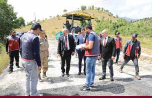
İl Özel İdaremiz tarafından yapımı devam eden Arıcak Üçocak Grup Yolu (4 km) sıcak asfalt serim çalışması
