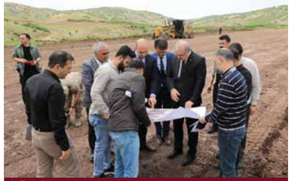
İl Özel İdaremiz tarafından küçükbaş hayvancılık ile uğraşan vatandaşlarımız için yapılan Hayvan Kışlak Alanı
